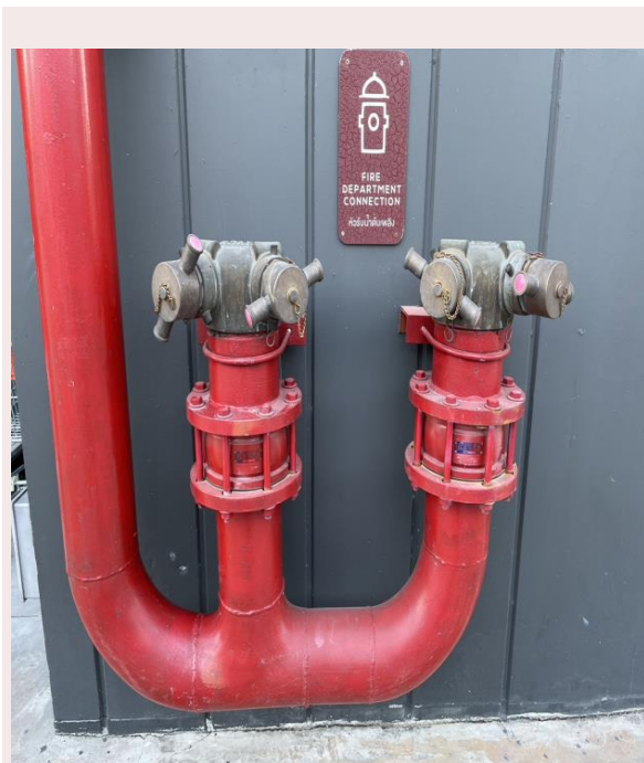
รูปที่ 2.4.6.1-1 หัวรับน้ำดับเพลิงภายนอกอาคาร
